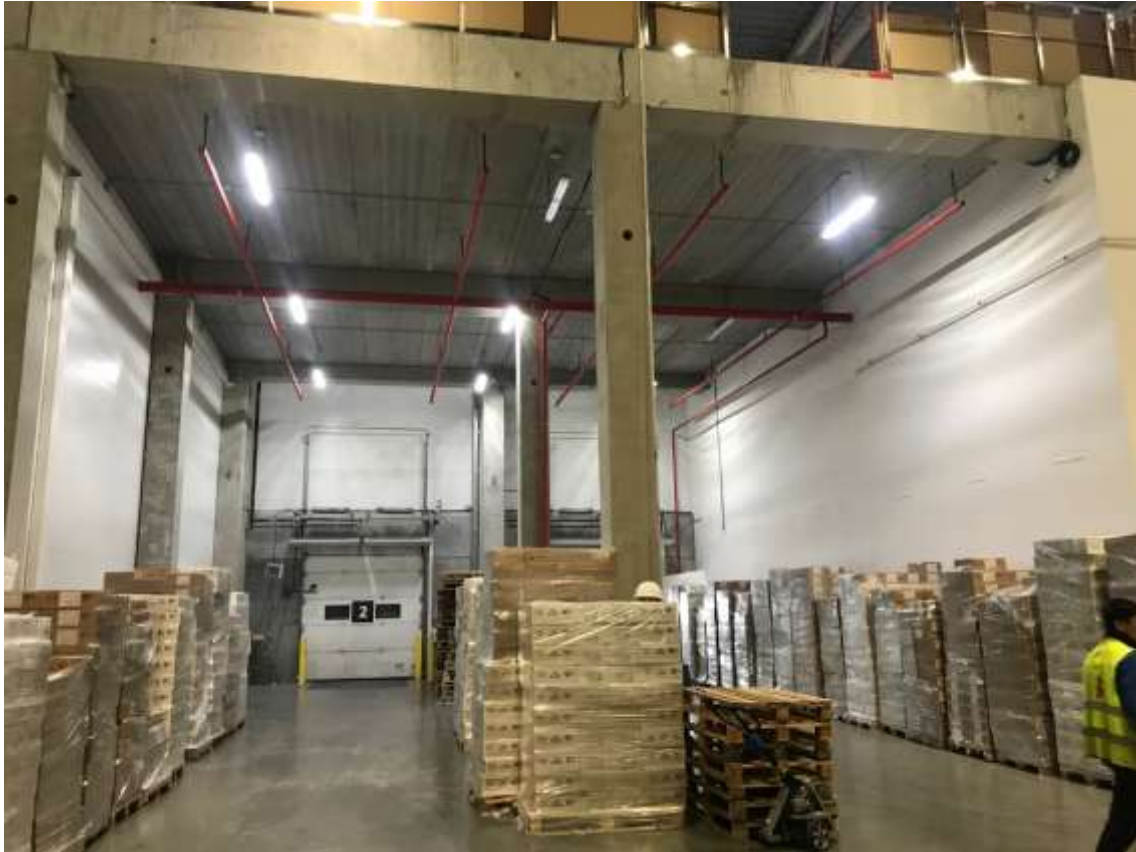
Фото № 14. Нежилое помещение оцениваемого здания
