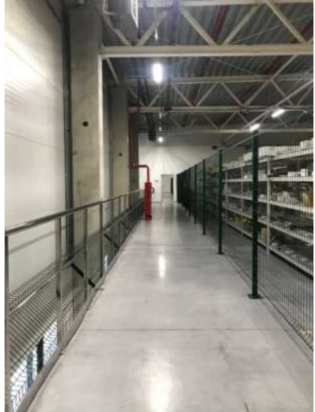
Фото № 17. Нежилое помещение оцениваемого здания
